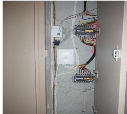
21-Exemple de BE positionné dans une gaine technique
