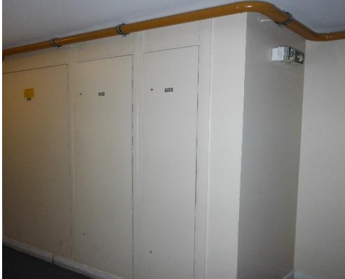
21-Exemple de BE positionné dans une gaine technique
